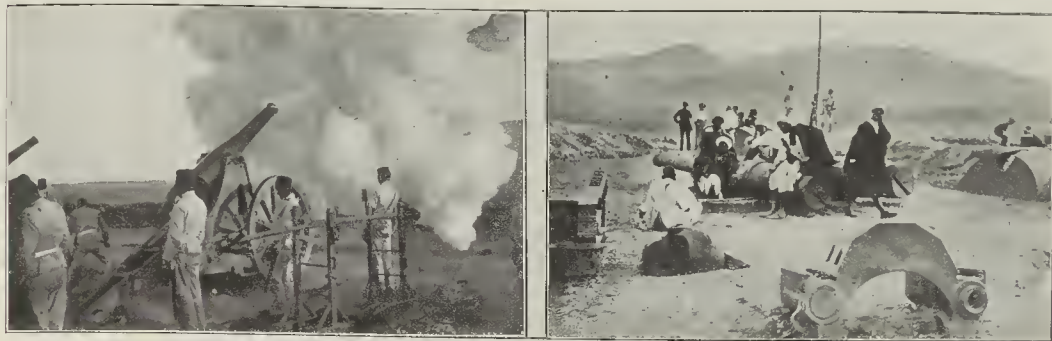
Cañones de 15 haciendo fuego por elevación sobre las cañadas del Gurugú, siguiendo las indicaciones hechas desde el globo cautivo Grupos de moros confidentes descesnando sobre cañones de grueso calibre antes de ser éstos montados
